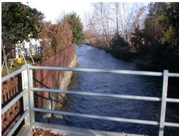
Figura. G5, Foto scattata tra gli abitati di Santandrà e Villorba. L'arginatura in cemento e la presenza di una recinzione creano una interruzione della copertura a siepi della sponda del corso d'acqua.
