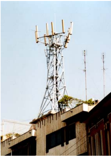
Foto 3 – Antenne di telefonia mobile (SRB)
